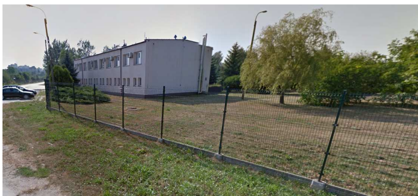
10.1.7. Gminny Punkt Zbiórki Odpadów Komunalnych – Ul. 1-go Sierpnia 18A – RUPIECIARNIA – punkt zbiórki surowców wtórnych i odpadów komunalnych. Obiekt wybudowany w 2013 r. – ogrodzony i oświetlony w porze
